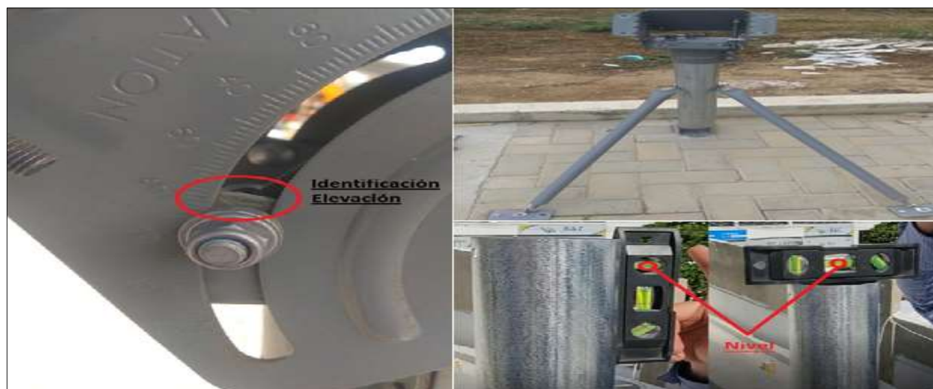
Ilustración 17. Nivelación.
