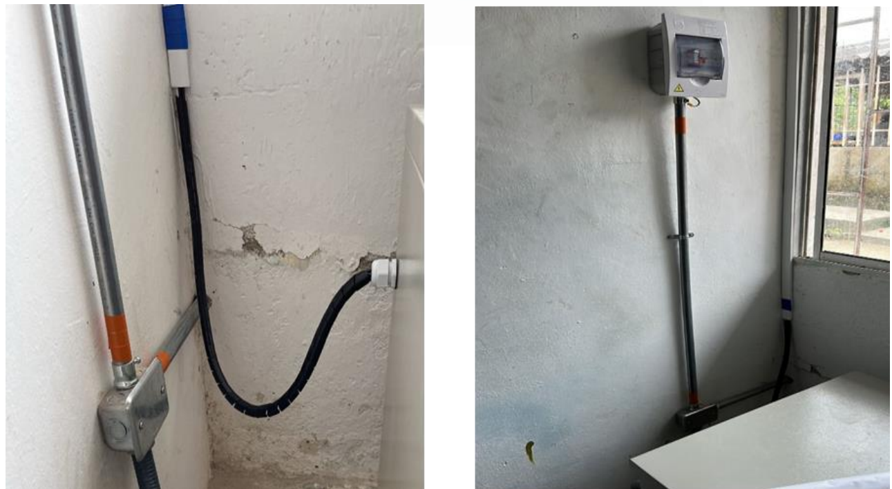
Ilustración 13 Señalización Tubería EMT
