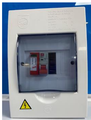
Ilustración 22 puente de la Fase en el Breaker 10
