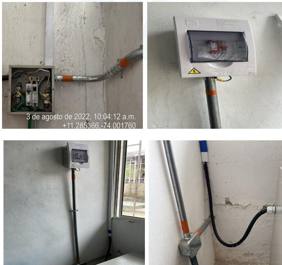
Ilustración 24 Recorrido tubería EMT, maquillado y aterrizado
