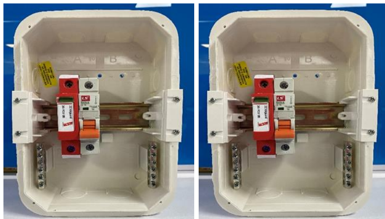
Ilustración 19 instalación DPS y el Breaker 10A en el barraje
