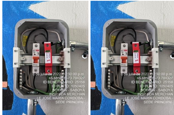
Ilustración 23 Instalación TDS en el CD
