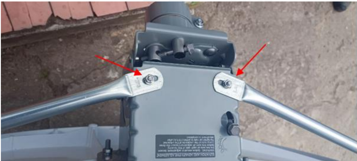
Imagen 5 Fijación vientos posteriores
