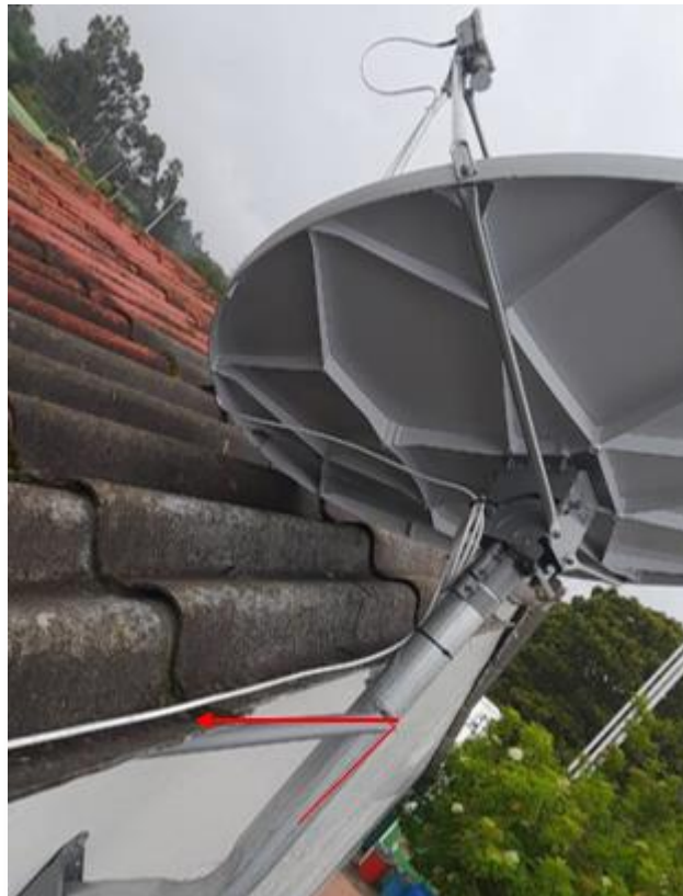
Imagen 13 Montaje final Antena Satelital 1.2m
