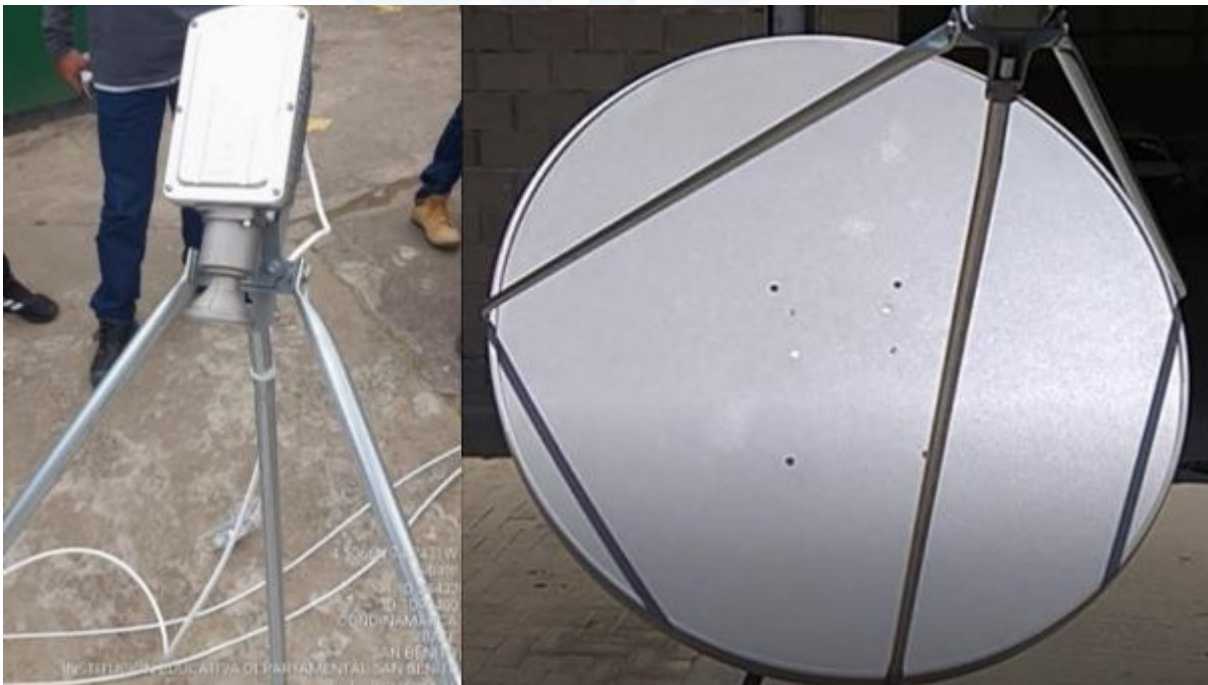
Imagen 7 Montaje final ODU
